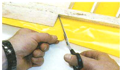
Obr. 12a Nářeznout 45° u vnitřních rohů.
